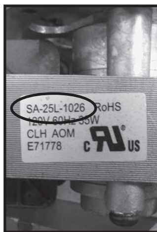
Fig. 79: Fan part number labels
